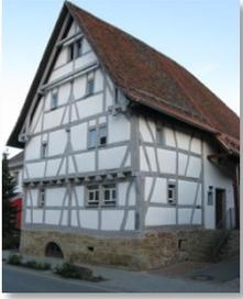
Das älteste Haus Zeuterns, das Firstständerhaus, wurde 1458 erbaut. Die Sommerstube entstand 1671 im vorderen Teil. Die Firstständerbauweise ist benannt nach den haushohen Ständern, die vom Fundament bis zum First reichen. Vollständig renoviert wurde das Haus von 2003 bis 2007. Heute wird dieses Haus für Trauungen und Veranstaltungen genutzt. Zwei Räume im Obergeschoß dienen musealen Zwecken.
