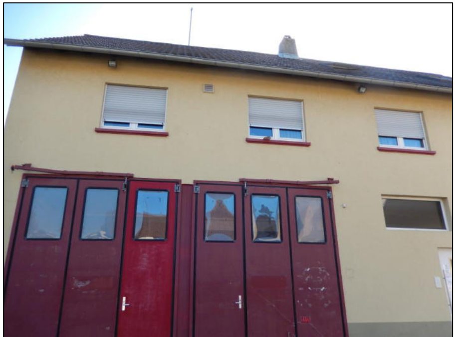
Foto 1: Blick auf die Fassade des alten Feuerwehr- hauses (Oberdorfstr. 19). Das Gebäude bietet Habitatpotenzial für spaltenbewohnende Fledermäuse sowie für Nischen- und Höhlen- brüter.
