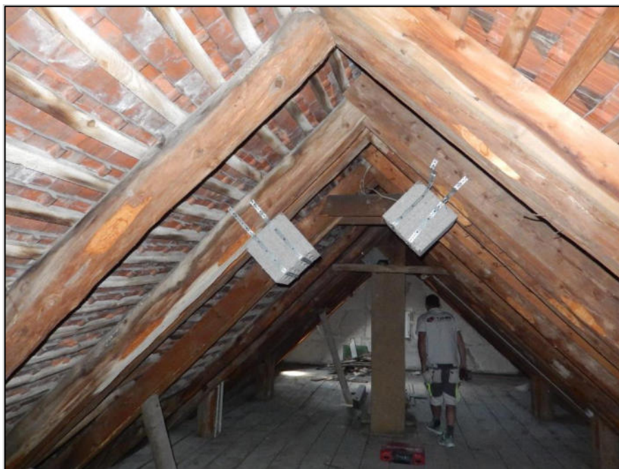
Foto 8: Beispiel: Hohlblocksteine im Spitzboden
