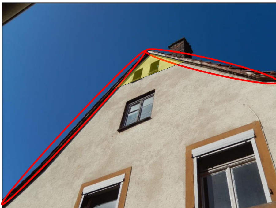
Foto 2: Die Ortgangziegel (rot) und die restlichen Dachziegel sind händisch abzunehmen und die Einflugöffnungen (obere offene Fenster) mit Folie so abzuhängen (gelbe Markierung), dass Fledermäuse noch heraus-, aber nicht mehr hineinfliegen können.
