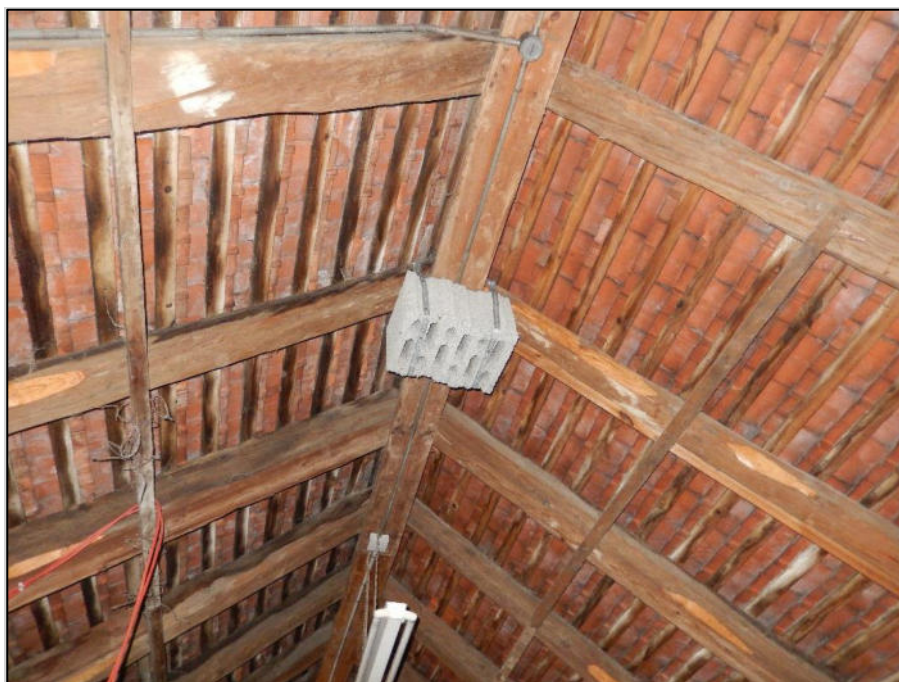
Foto 9: Beispiel: Hohlblocksteine am First
