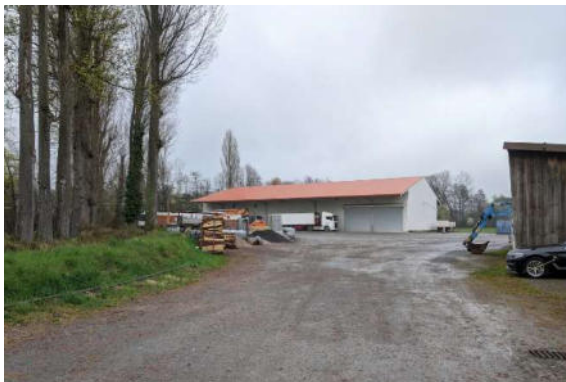
Bild 3: Blick von Westen auf Hallengebäude
