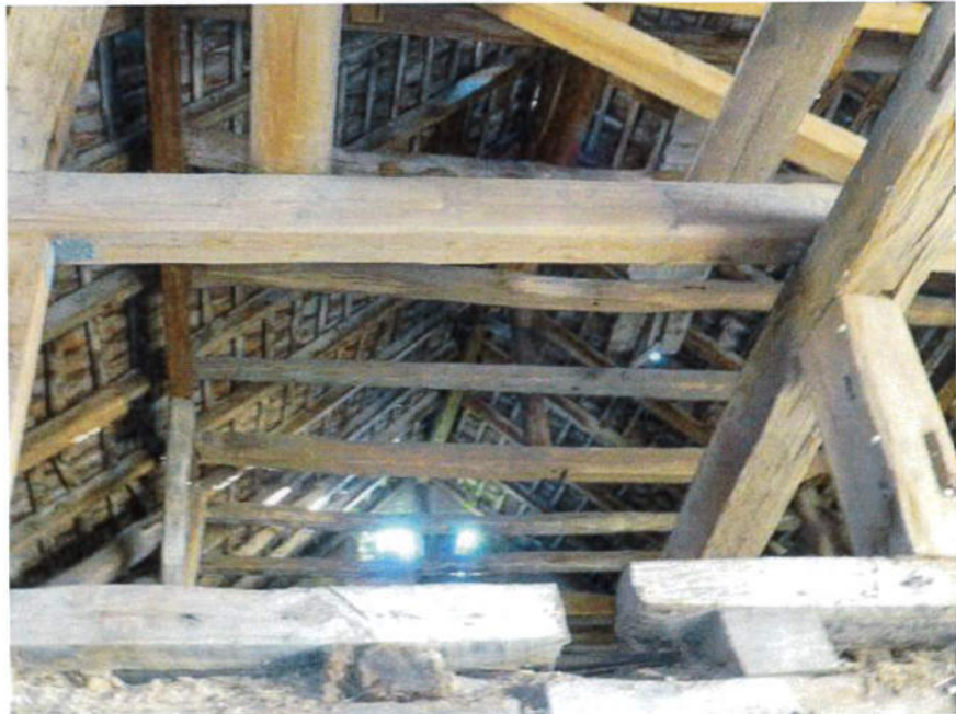
Foto 9: Dachstuhl mit Einflugmöglichkeiten und potentiellen Quartierstrukturen
