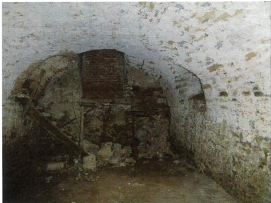
Foto 10: Grundsätzlich als Winterquartier geeigneter Gewölbekeller mit zahlreichen geeigneten Mauerspalten
