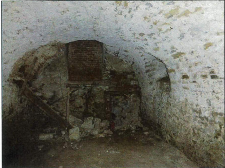
Foto 5: Der Gewölbekeller könnte potentiell Fledermäusen als Winterquartier dienen.
