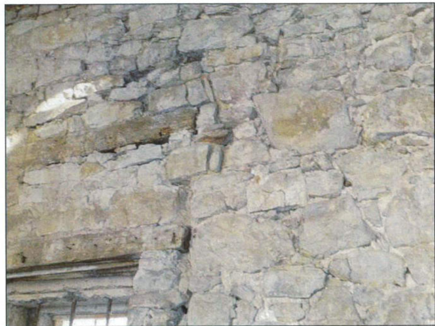
Foto 4: ...und in den aus Natursteinen gemauerten Gebäudewänden, die zahlreiche Nischen aufweisen.
