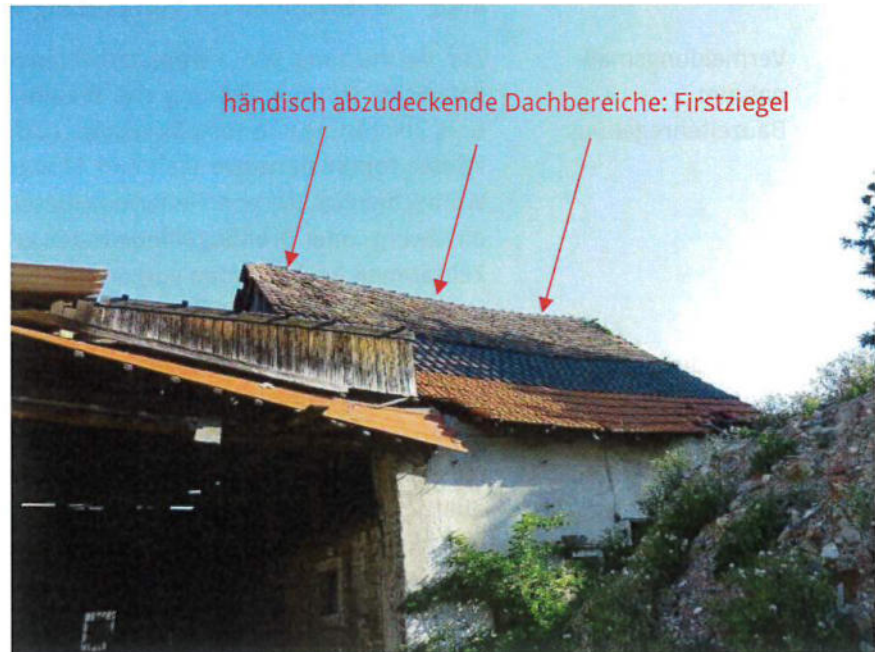
Foto 18: Vor dem Rückbau händisch abzudeckende Dachbereiche
