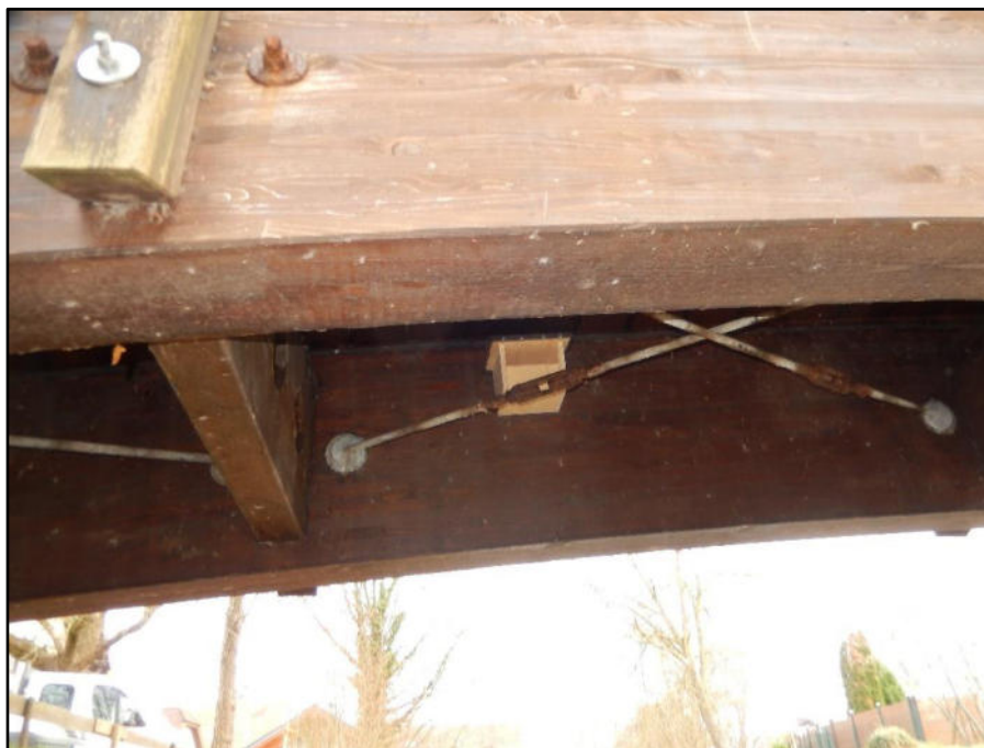
Foto 12: Nischenbrüterkasten unter der Brücke des Kraichbachs südlich der Feuerwehr
