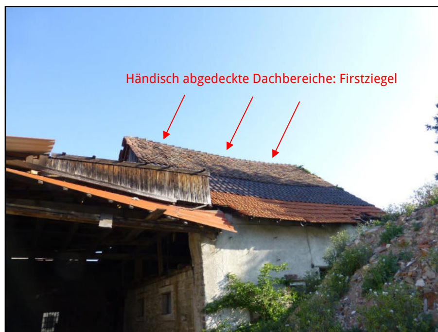
Foto 6: Am 09.11.2021 händisch abgedeckter Dachbereich (Foto zeigt First vor Abdeckung)
