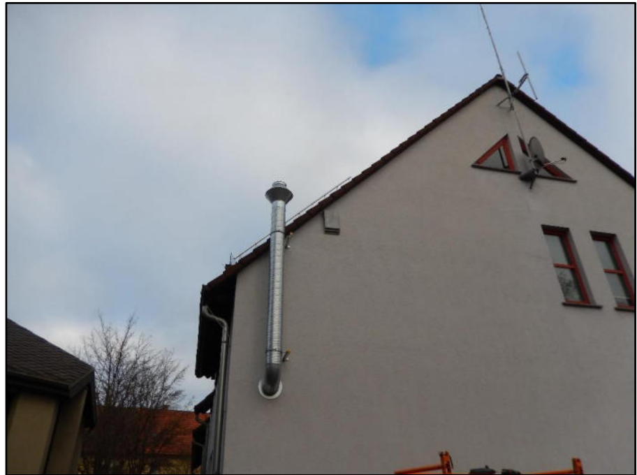
Foto 8: Südwestexponierter Fledermauskasten am Feuerwehrgebäude
