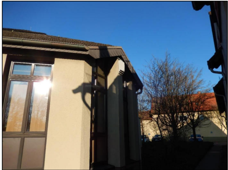
Foto 10: Südostexponierter Fledermauskasten am Gebäude der Gemein- deverwaltung
