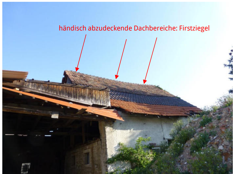
Foto 18: Vor dem Rückbau händisch abzudeckende Dachbereiche
